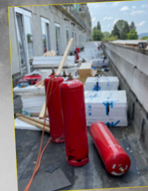
Flüssiggasflaschen ohne Kippschutz und direkt neben dem Regenlauf. Und weit und breit kein Feuerlöscher!
